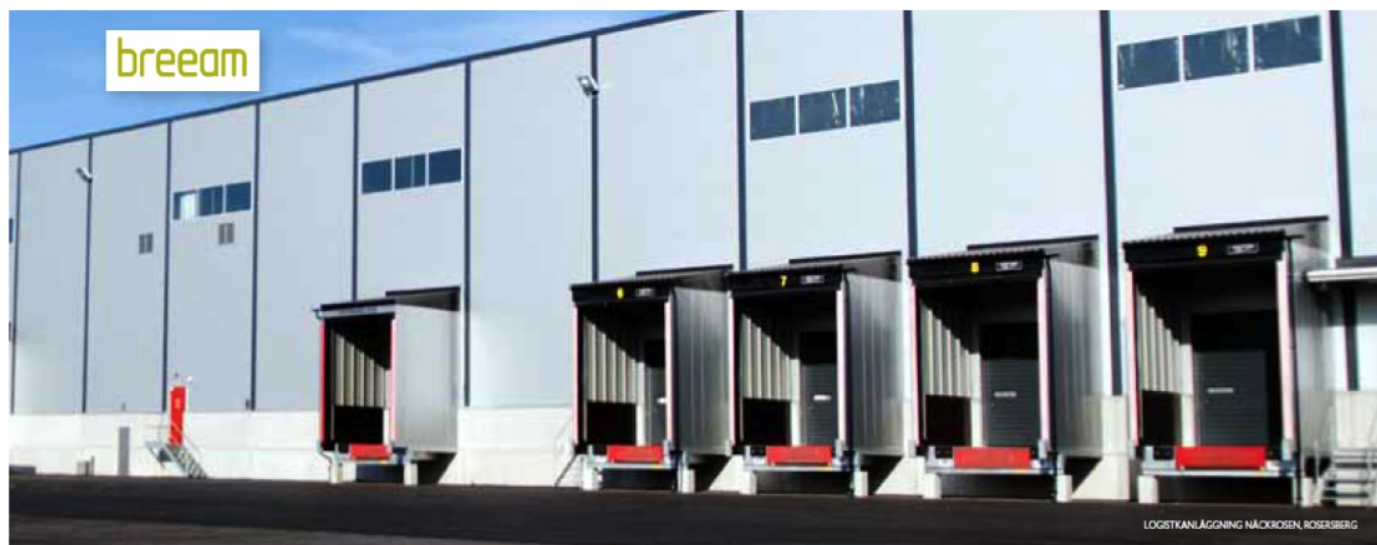
Maskrosen Logistikanläggning, Rosersberg © NCC Construction Sverige
